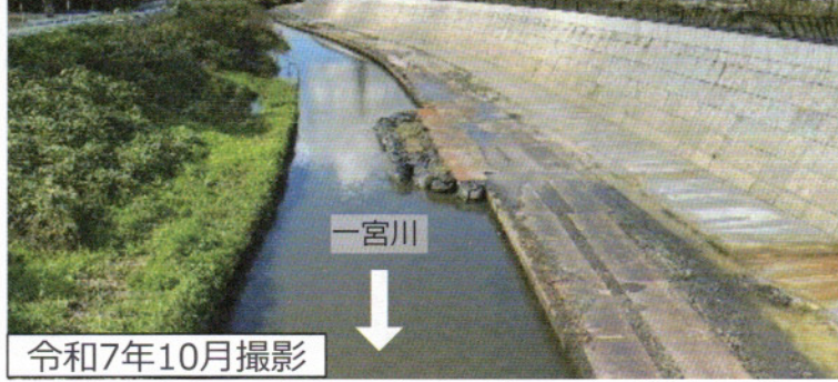
令和7年10月撮影 【護岸法立区間】茂原市茂原地先 (日進橋上流)
