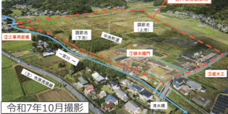
令和7年10月撮影 【一宮川第三調節池】排水樋門、遮水工等
