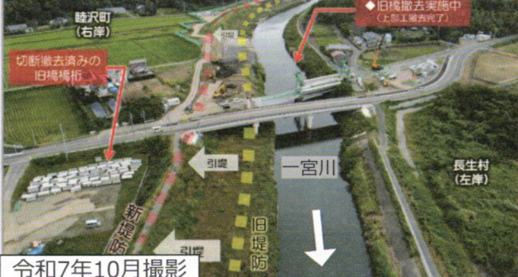
令和7年10月撮影 【河道拡幅区間】北川橋橋梁架け替え工事
