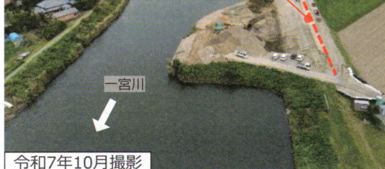
令和7年10月撮影 【河道掘削区間】長生村金田地先 (松潟堰上流)
