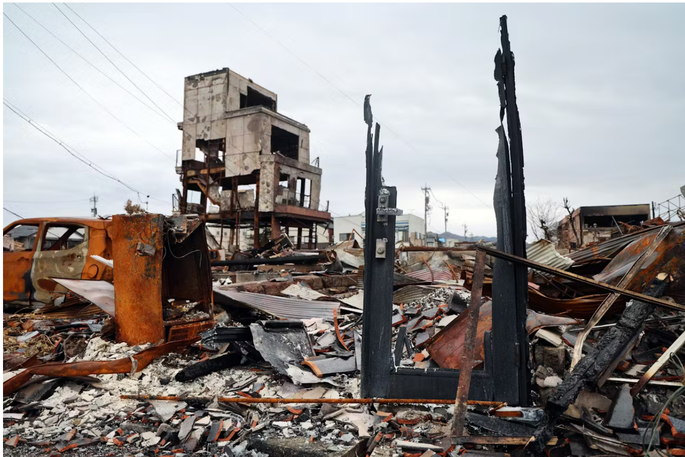
地震後に大規模な火災があった「輪島朝市」付近（2024年1月、石川県輪島市）
