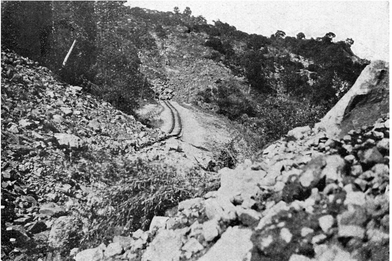
関東大震災では火災のほかに土砂災害も多発した（旧国鉄根府川・真鶴駅間の土砂崩れ）=土木学会附属土木図書館提供
